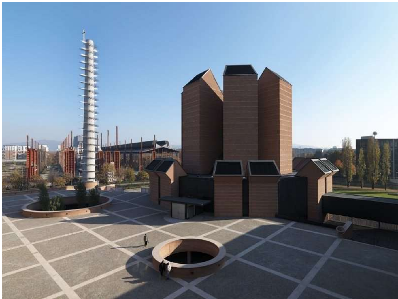
Рис. 4. Церковь Святого Лика. Турин, Италия, архитектор Марио Ботта, 2006 г. Общий вид.
