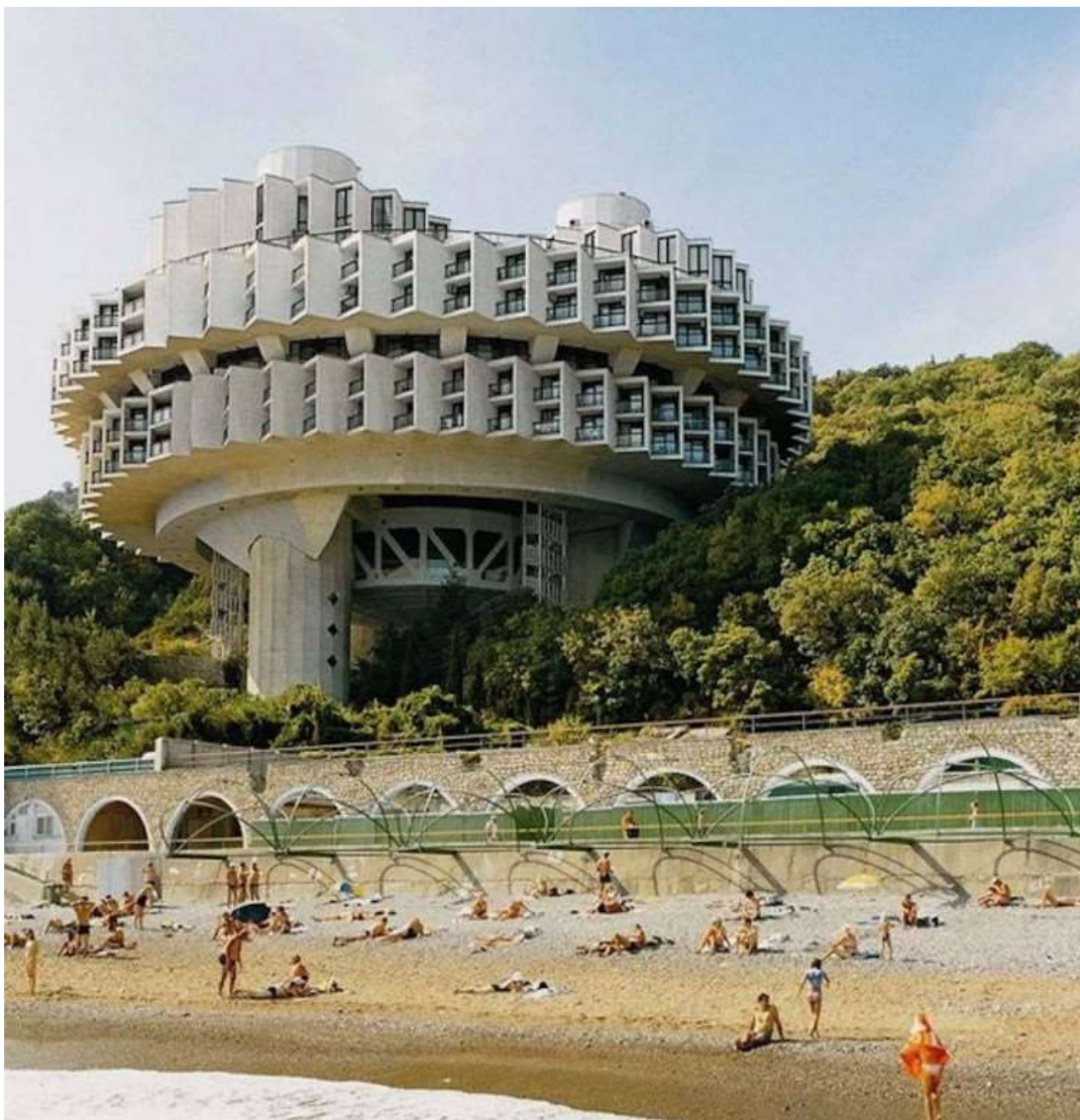
Рис. 1. Международный пансионат «Дружба», г. Ялта, Россия, руководитель проекта заслуженный архитектор РФ И. Василевский, архитектор Ю. Стефанчук, главный конструктор заслуженный строитель РФ Н. Канчели, 1985 год. Общий вид.
