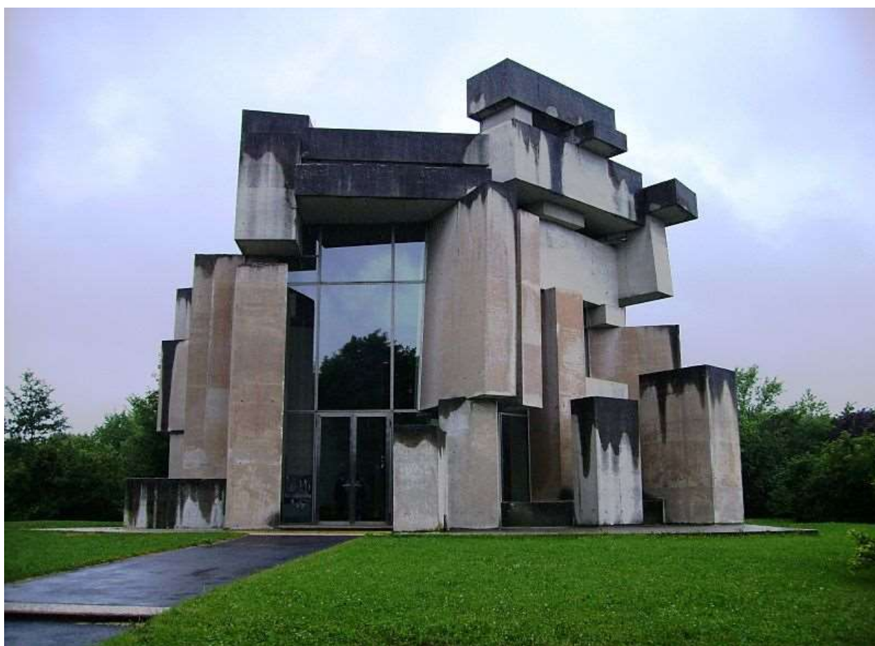
Рис. 1. Храм Вотрубы. Вена, Австрия, архитектор Фриц Вотруба, 1976 г. Общий вид.
