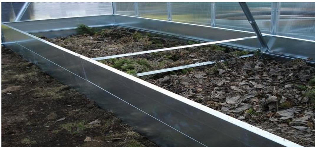
Рисунок 5 -Отделка внутреннего обустройства, оцинкованные грядки
