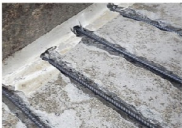
Иллюстрация 1а . Установка арматуры 1
