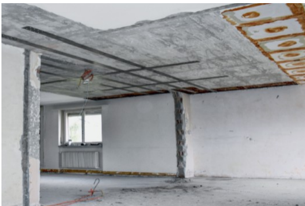
Иллюстрация 6. Вид установленных пластин после сноса несущей стены
