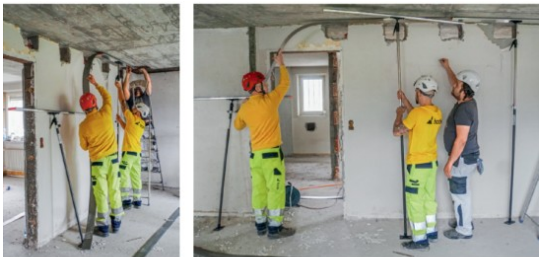
Иллюстрация 4. Процесс монтажа металлических пластин СПФ
