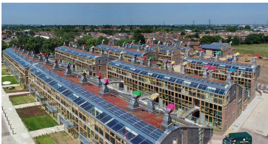
Рис.2 Жилой и офисный экокмплекс Beddington Zero Energy Development, г. Лондон, Великобритания
