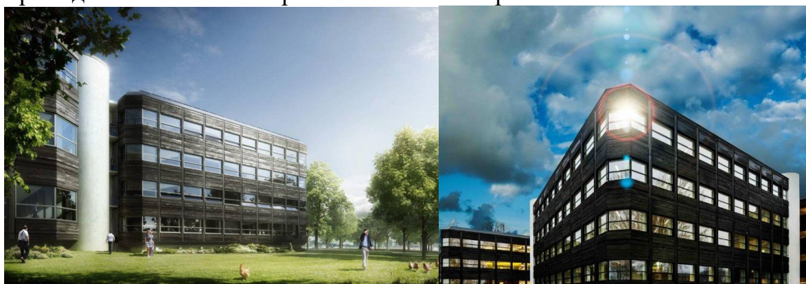
Рис. 3 Энергопозитивное офисное здание Power house Kjørbo, г. Осло, Норвегия
