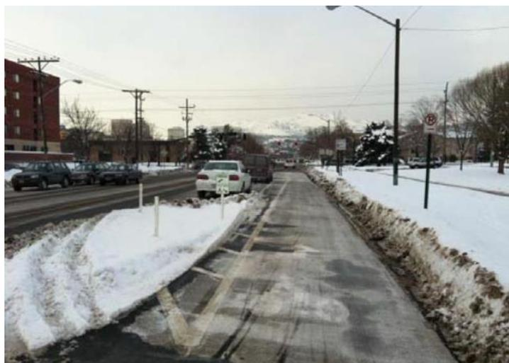
Рисунок 1 - Защищённая велодорожка в Солт Лейк Сити (США) со складированием снега на буферной разделительной полосе
