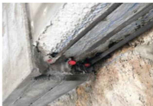
Иллюстрация 2. Зона крепления арматуры d16 из СПФ в мостовую балку
