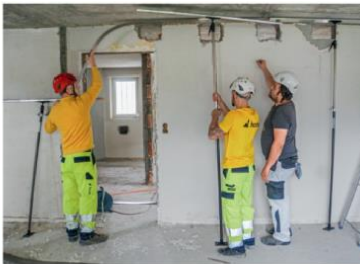
Иллюстрация 4. Процесс монтажа металлических пластин СПФ
