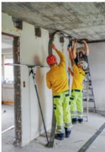
Иллюстрация 4. Процесс монтажа металлических пластин СПФ
