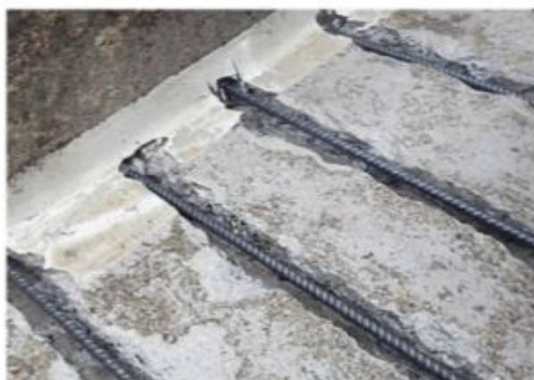
Иллюстрация 1а . Установка арматуры 1
