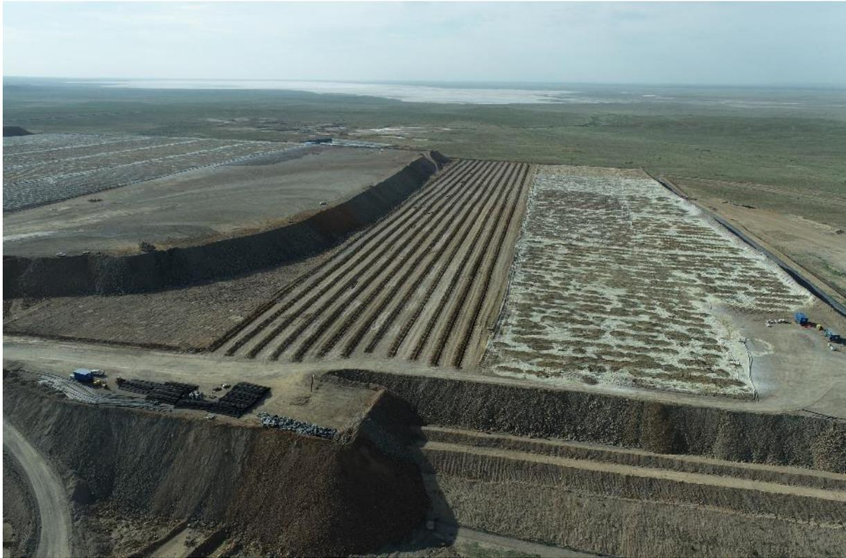
Рис.8 ПКВ-2. Укладка стрингерных труб системы принудительной аэрации
