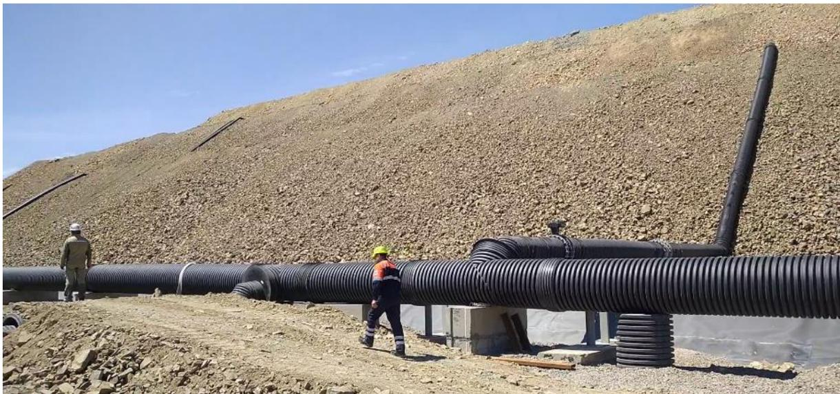
Рис.9 ПКВ-2. Коллектор подачи воздуха
